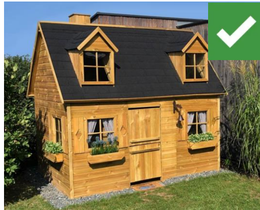
Unterkonstruktion mit Plane und Kies
